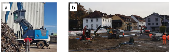
Abb. 2: Einsatzorte mit aktiven mobilen Maschinen und Fußgängern: (a) Metallschrottplatz, (b) Straßenbaustelle.
